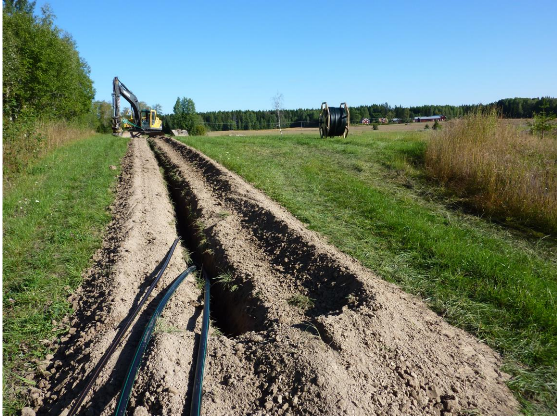
Bredband håller på att byggas. Närmare 90 % av bygdens hushåll har anslutit sig.
